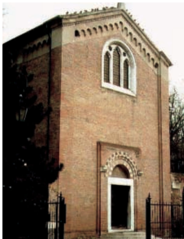
Fig. 23 - La facciata della Cappella prima del restauro The façade of the Chapel before restoration
